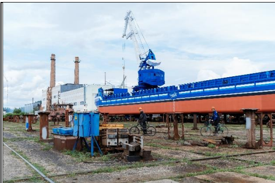
Наплавной мост через р. Конда
